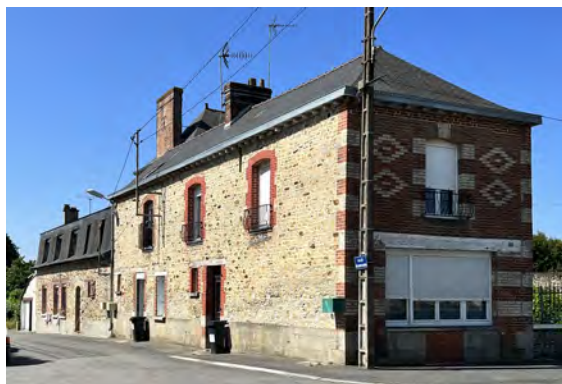
« Eventrement » des rez-de-chaussée
