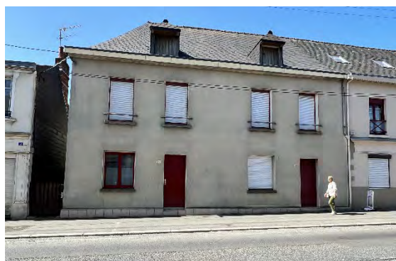
« Banalisation » d'une façade
