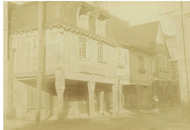
Maison au dernier plan © ministère de la Culture (France), Médiathèque du patrimoine et de la photographie
